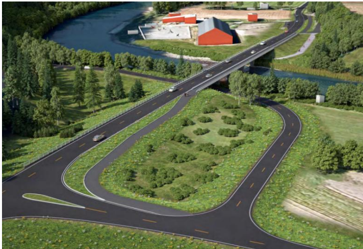
Ny Elverhøy bru i Sunndal ble ferdigstilt i juni 2024.
