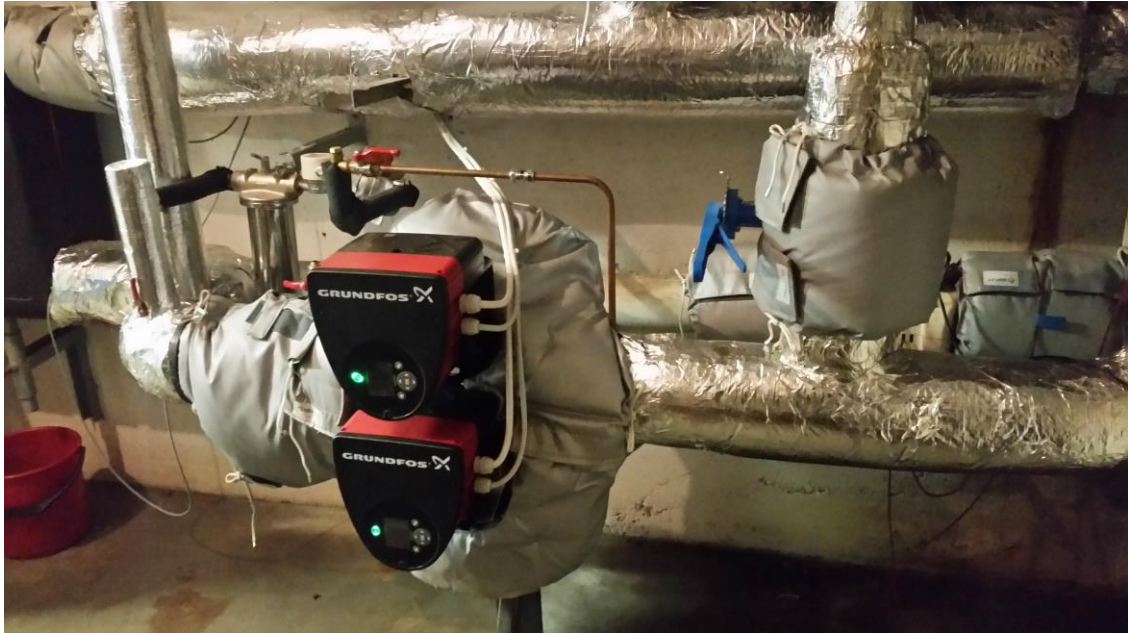
Bilde 17. Skifte av pumper og isolering av rør, Tingvoll barne- og ungdomsskole.
