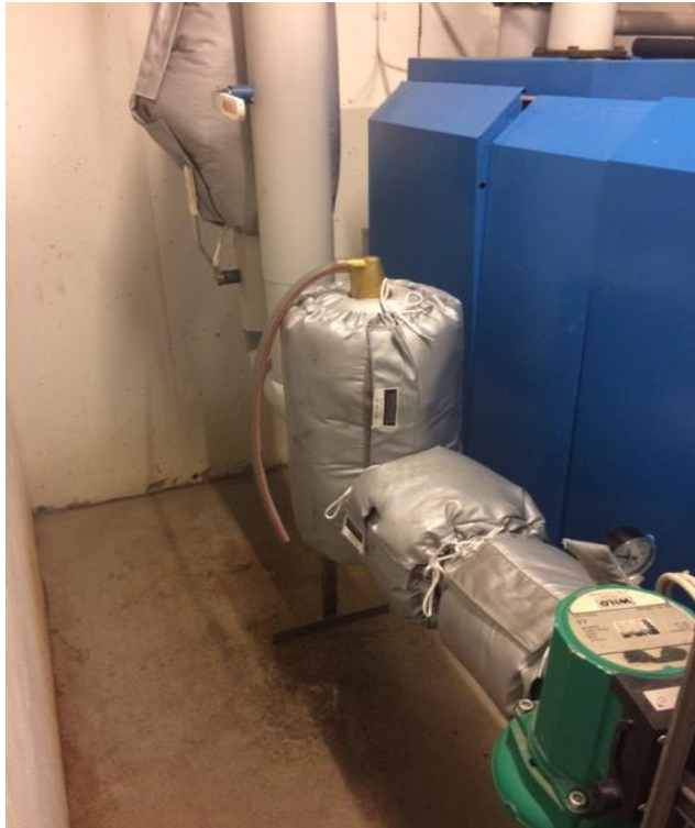
Bilde 12. Etter-isolering av varmeanlegg. Foto: Surnadal kommune
