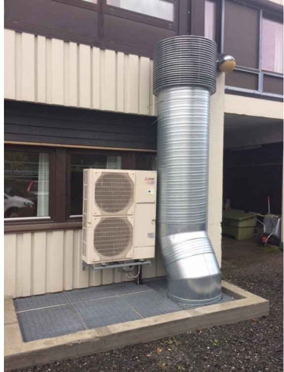
Bilde 13. Utedelen til varmepumpen er montert over avkastet fra ventilasjonsanlegget. Foto: Surnadal kommune
